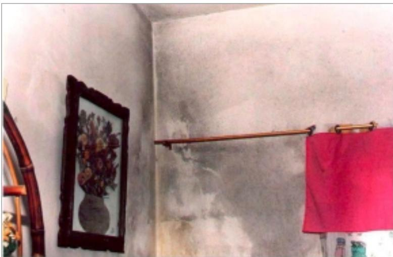
Por otra parte, se minimizan las reales condiciones de uso al no considerarse el efecto concurrente de distintas fuentes de humedad que pueden estar afectando simultáneamente un dado paramento y alterando sustancialmente su comportamiento higrotérmico. **Un muro húmedo por infiltración, capilaridad o condensación intersticial, con sus poros saturados de agua posee**
